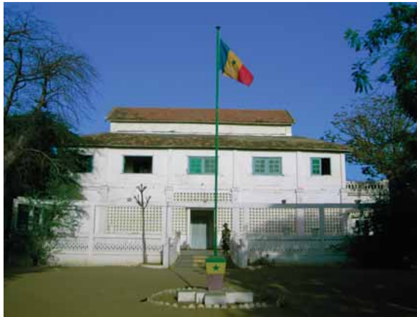
Bâtiment colonial abritant la Gouvernance de Matam
